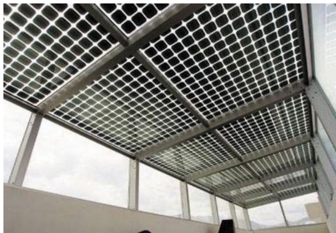
Εικόνα 10: Φωτοβολταϊκό σύστημα- ενσωματωμένο σε κτίριο
