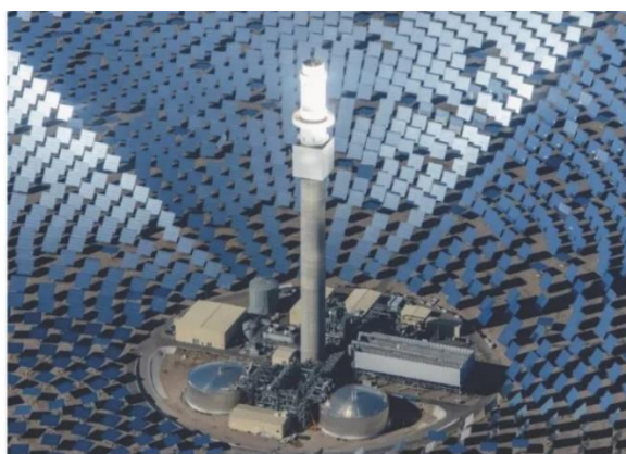
Εικόνα 4: Ηλιοστάτες/κάτοπτρα σε ηλιοθερμικό εργοστάσιο στη Βόρεια Αφρική.
