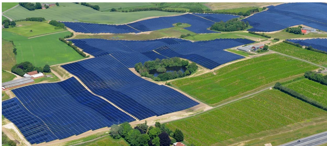
Εικόνα 34: Σύστημα ηλιακής τηλεθέρμανσης στο Silkeborg της Δανίας.
