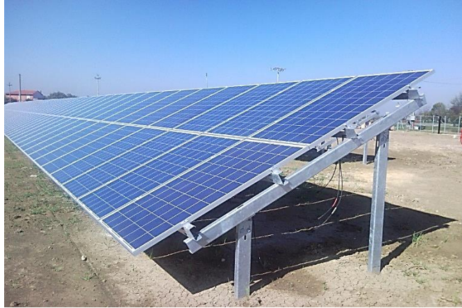
Εικόνα 2.9: Έδραση φωτοβολταϊκών με εδαφόμψη (Industrias Duero, 2019)
