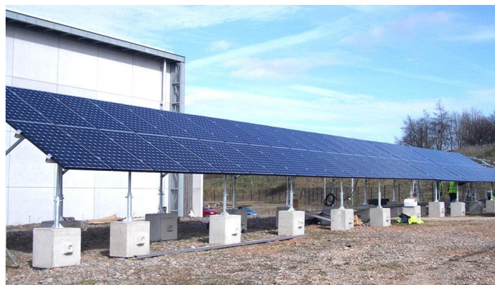
Εικόνα 2.11: Έδραση φωτοβολταϊκών σε πέλματα από σκυρόδεμα (Elite, 2019)
