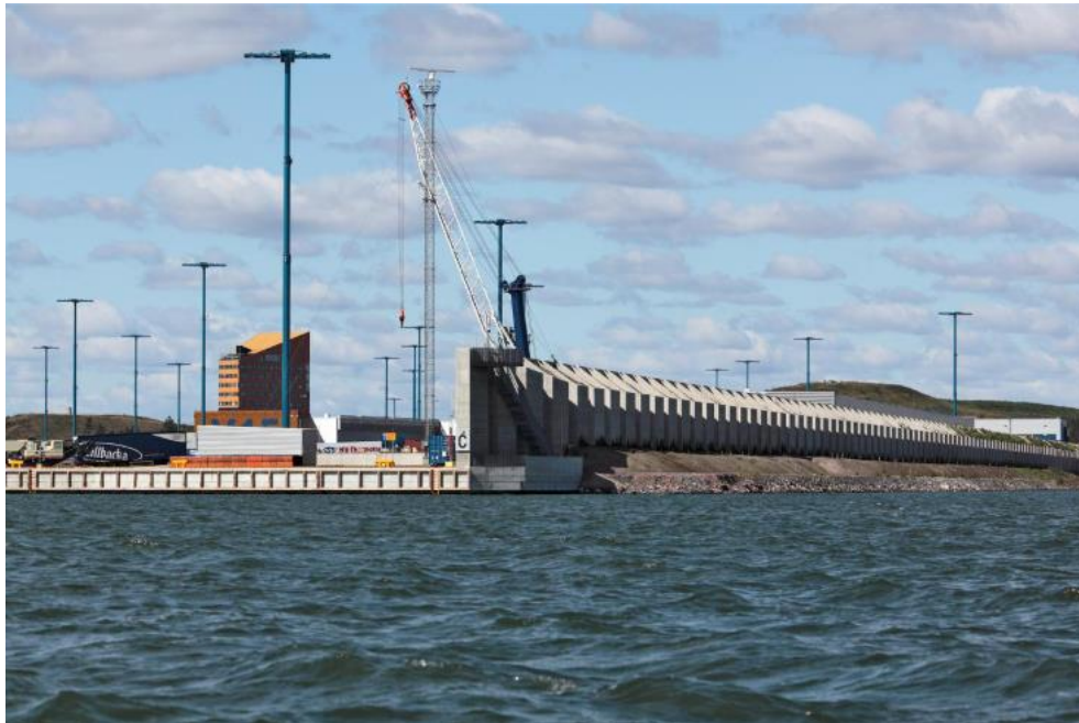
Εικόνα 2: Τοίχος για την αποτροπή της ηχορύπανσης - Λιμένας Ελσίνκι (PENTA Project, 2013)
