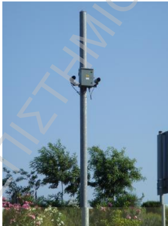
Ανιχνευτής Υπερβάλλοντος Ύψους Οχημάτων (OHVD)
