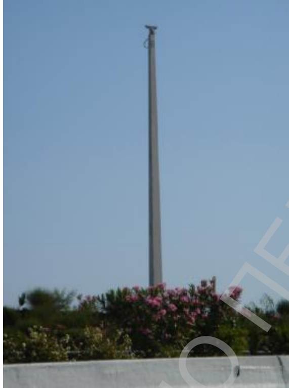
Κλειστό Κόκλωμα Τηλεόρασης (CCTV) (ανοικτός δρόμος)
