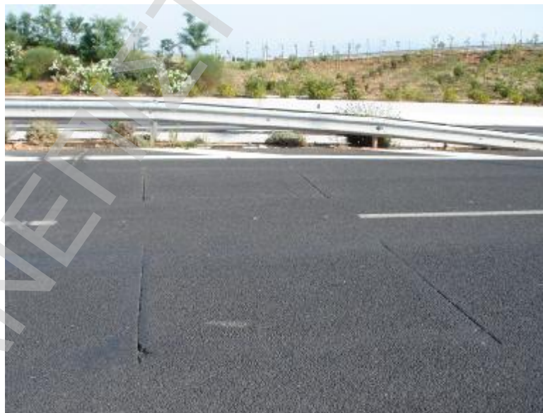
Επαγωγικός Βρόγχος (Loop) Ανίχνευσης Οχημάτων
