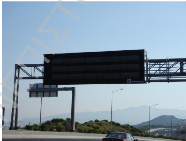
Πινακίδα Μεταβλητών Μηνυμάτων Main Variable Messages Sign (MVMS)
