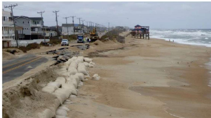
Εικόνα 15: Η διάβρωση του οδικού δικτύου της ακτογραμμής μετά από καταιγίδα
