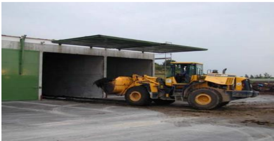
Φωτογραφία 4.3: Χωνευτήρας τύπου γκαράζ, τροφοδοτούμενος από φορτωτή
