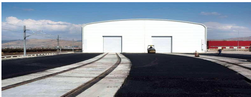
Εικόνα 11: Κτίριο Πλάγιας πύλης Χώρου Εξυπηρέτησης Εμπορευματοκιβωτίων
