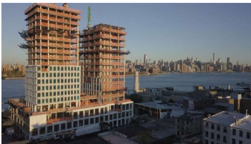
Εικόνα 3.8.: Χρησιμοποιώντας την εκτύπωση 3D για την αποκατάσταση της πρόσοψης του εργοστασίου ζάχαρης του Domino στη Νέα Υόρκη
