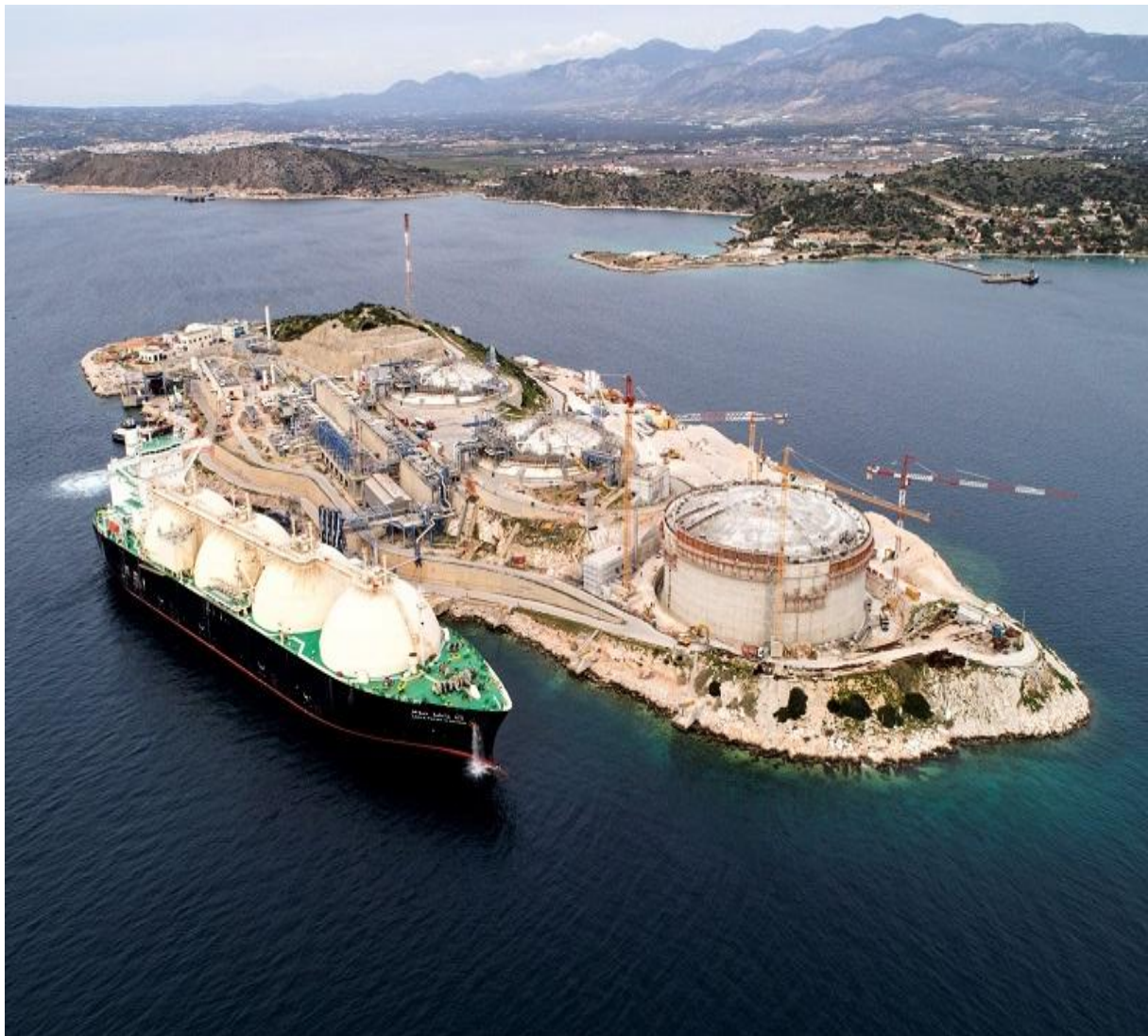
Εικόνα 7: Ο τερματικός σταθμός LNG της Ρεβυθούσας, Πηγή: energyin.gr
