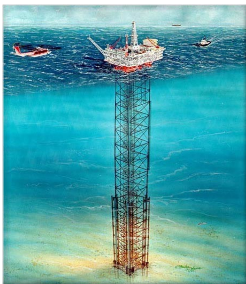
Εικόνα 2.5. Συμβατός Πύργος (Compliant Tower)- Τύπος σταθερής πλατφόρμας υπεράκτιας εξόρυξης
