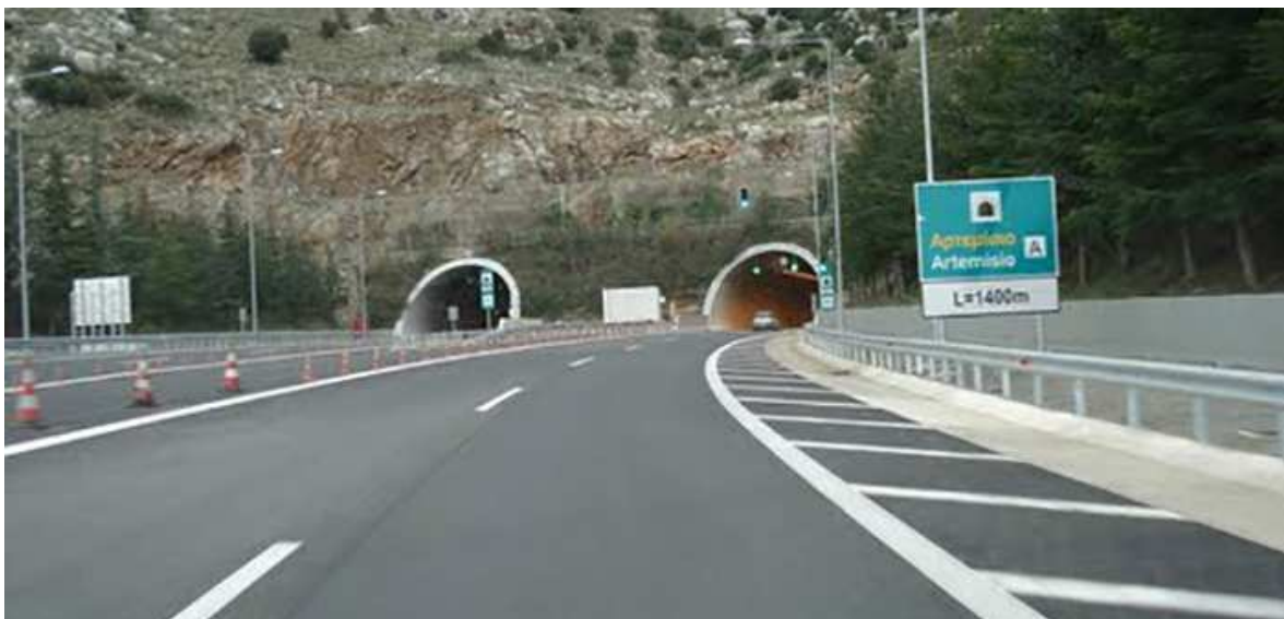
Εικόνα 4 – Σήραγγα Κατηγορίας A
