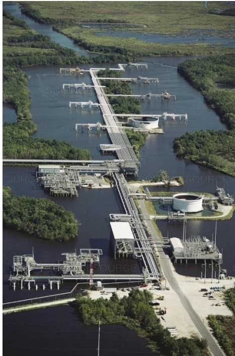
Εικόνα 5-3: Clovelly Dome Oil Storage Terminal
