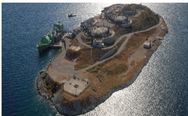
Εικόνα 7: Τερματικός σταθμός Υγροποιημένου Φυσικού Αερίου
