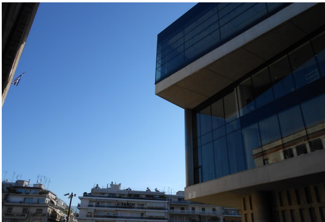
Εικόνα 8 Το κτίριο σε σχέση με τις πολυκατοικίες της περιοχής
