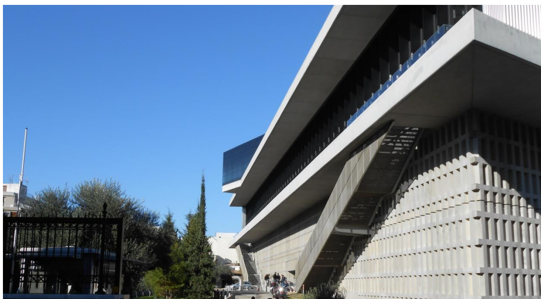
Εικόνα 6 Η βόρνη πλευρά του κτιρίου
