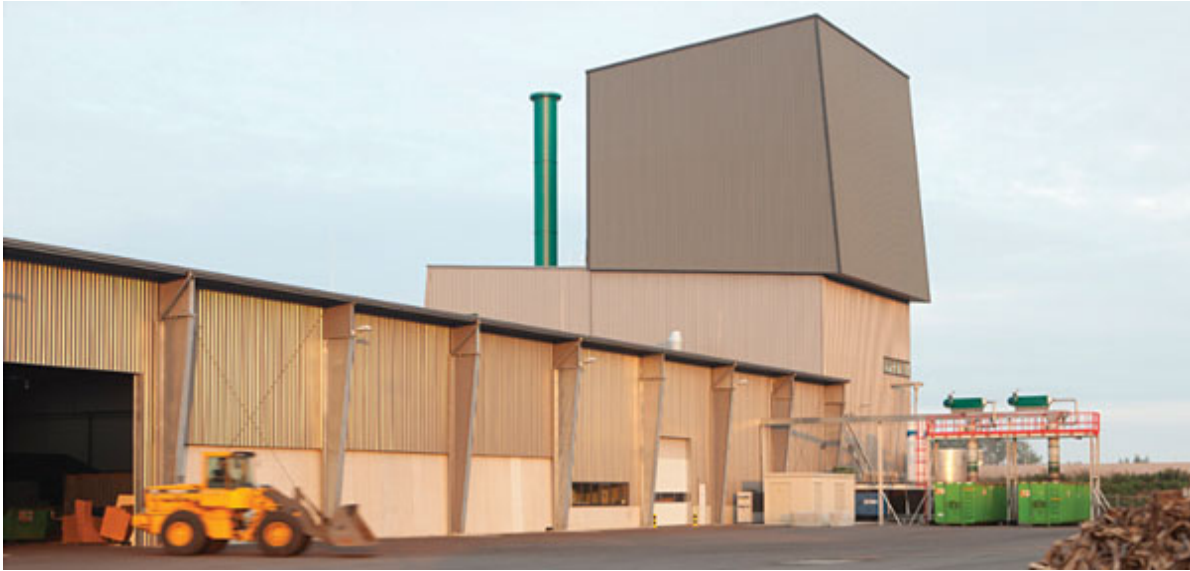
Εικόνα 17: Εργοστάσιο παραγωγής που επεξεργάζεται θερμικά λιγνοκυτταρινούχα βιομάζα με τη μέθοδο torrefaction στην Ολλανδία.
