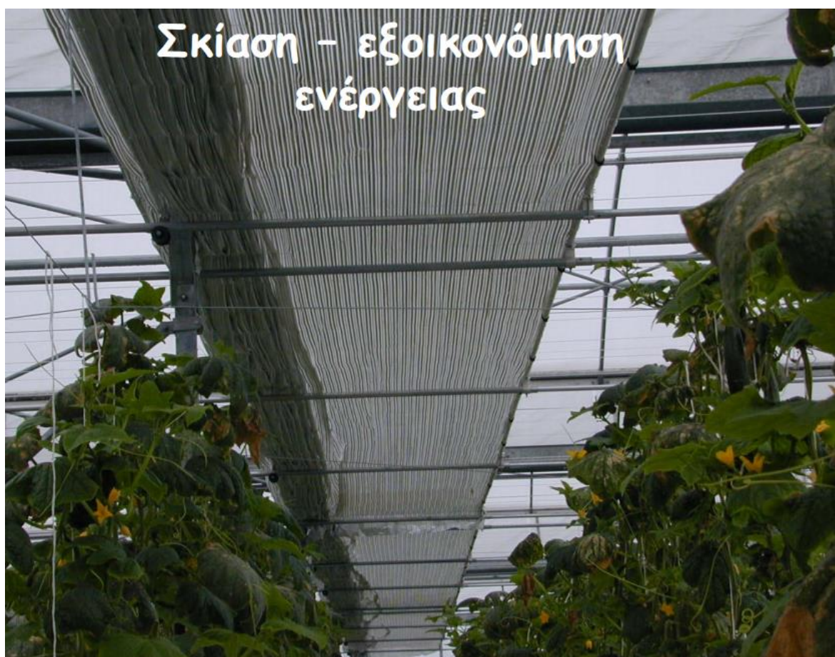
Εικόνα 3 Σύστημα κινητών κουρτινών σκίασης
