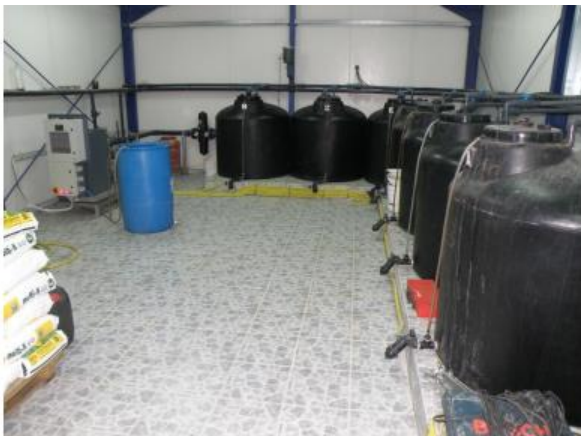
Εικόνα 5 Κεφαλή υδρολίπανσης
