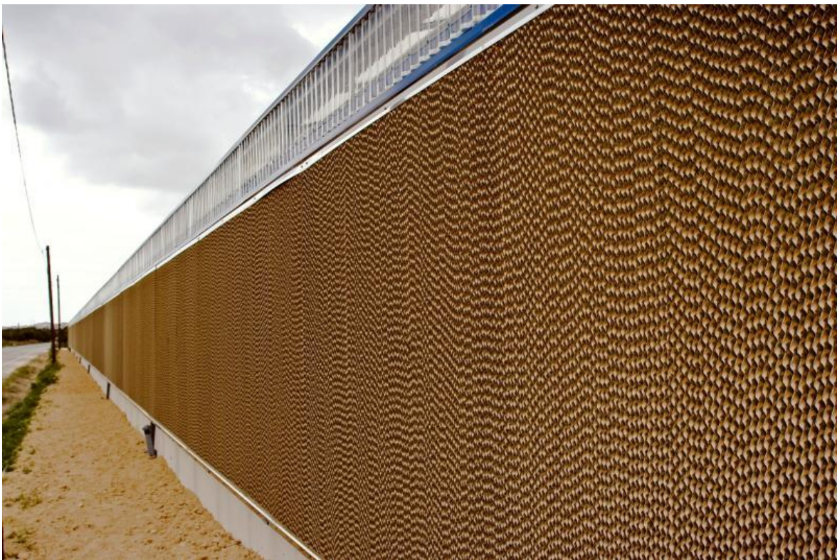
Εικόνα 2 Σύστημα δροσισμού με χρήση υγρής παρειάς
