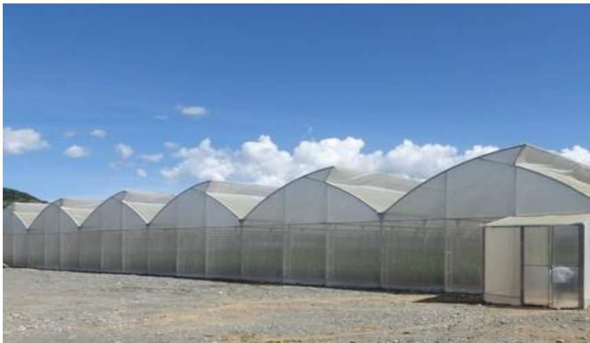
Εικόνα 1 Θερμοκήπιο γοθθικό ή τροποποιημένο τοξωτό
