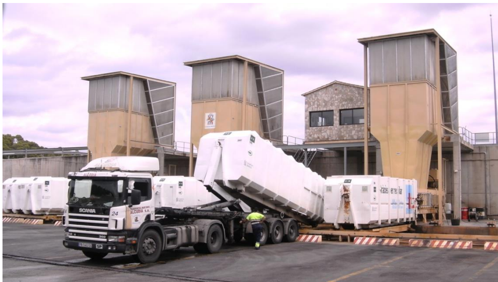
Εικόνα: Σταθμός Μεταφόρτωσης στην Mallorca
