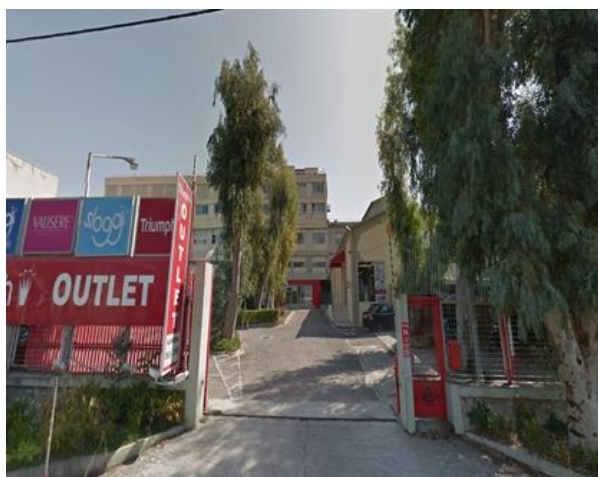
Εικόνα 18 Εγκαταστάσεις στο Περισσό
