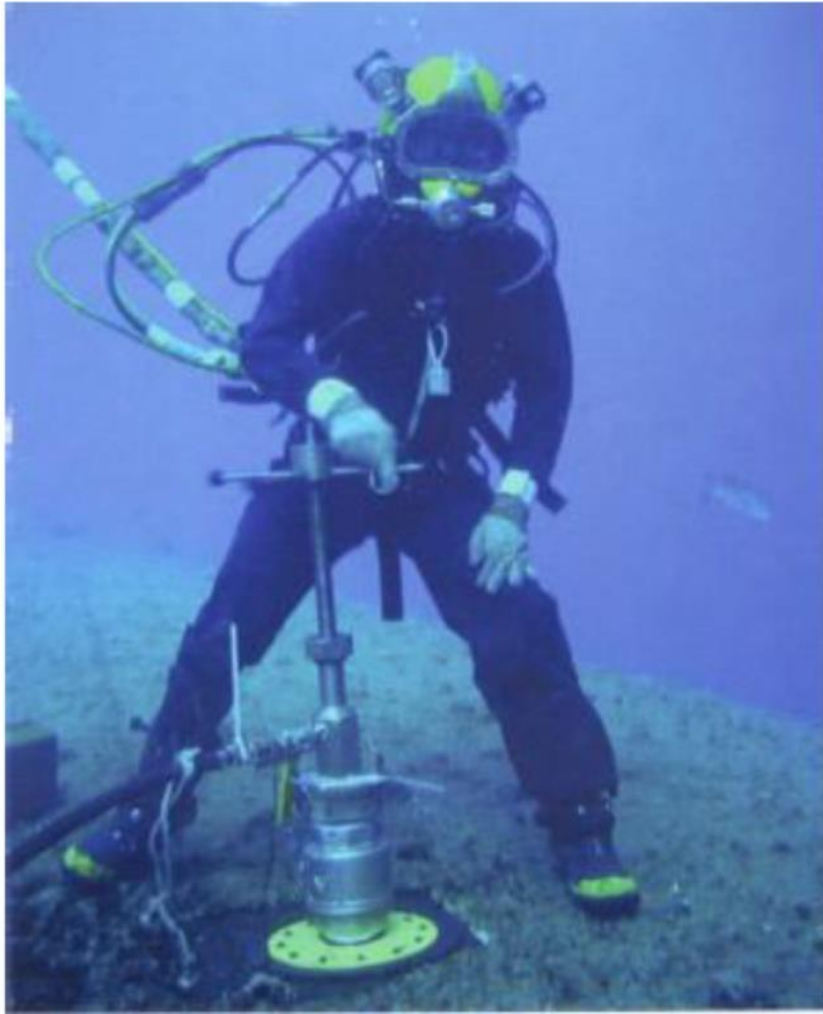
Εικόνα 24. Εγκατάσταση hot-tap από δύτη (Αργυρού Ν., 2010).
