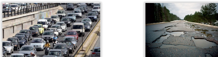
Εικόνα 3 Κυκλοφορική συμφόρηση και κακοτεχνίες οδοστρώματος.
