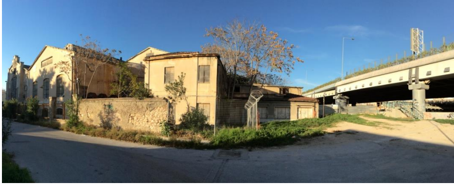
Εικόνα 4.7: Άποψη του ΑΗΣ Φαλήρου από τη μεριά της εισόδου. Στα δεξιά βλέπουμε τον Κηφισό
