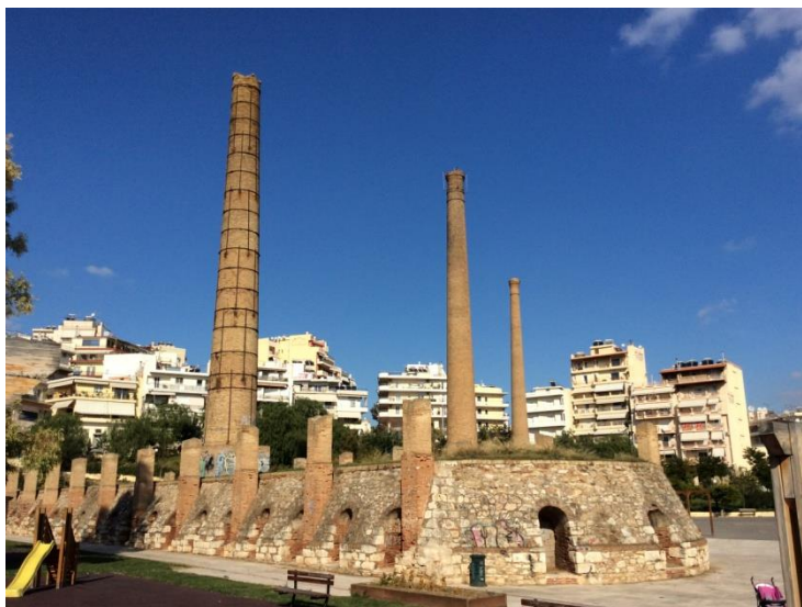
Εικόνα 3.3: Υψικάμινοι κεραμοποιίας Δηλαβέρη. Η κεραμοποιία ιδρύθηκε το 1902 από τον Ευστάθιο Δηλαβέρη. Το 1982 διακόπτει τη λειτουργία της και με διαθήκη του Κρίτωνα Δηλαβέρη, γιου του ιδρυτή, παραχωρείται στο δήμο Πειραιά. Το μεγαλύτερο μέρος των εγκαταστάσεων καταβυθίστηκαν το 1985.
