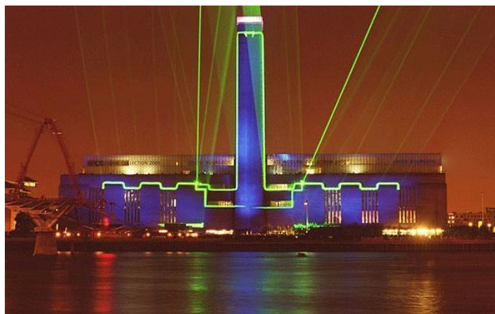
Εικόνα 4.4: Άποψη του Bankside Power Station κατά τον εορτασμό των 10 χρόνων λειτουργίας ως Tate Modern
