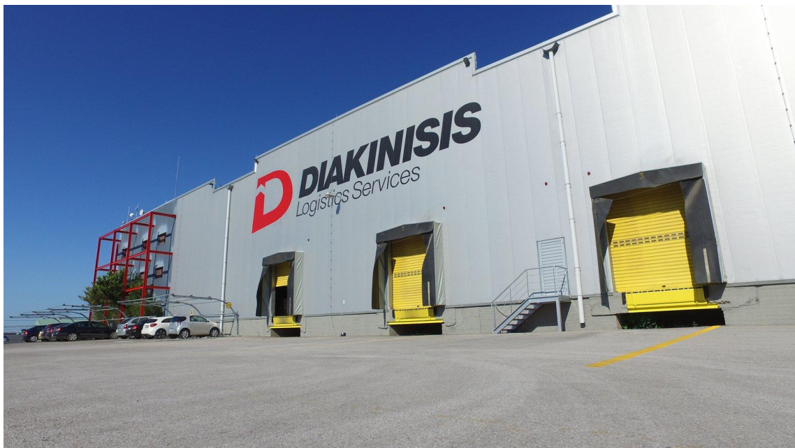
Εικόνα 4 Ράμπες φορτοεκφόρτωσης της εγκατάστασης, από όπου εκτελούνται τα ημερήσια δρομολόγια διανομής προς τα σημεία παράδοσης (Πηγή: DIAKINISIS, 2022)
