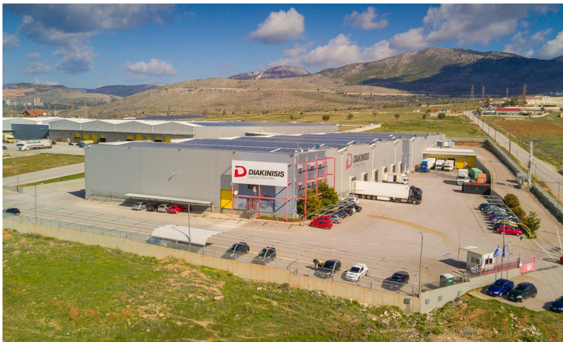
Εικόνα 3 Εξωτερική άποψη της φαρμακευτικής εγκατάστασης της ΔΙΑΚΙΝΗΣΙΣ στον Ασπρόπυργο, όπου διακρίνονται οι ράμπες φορτοεκφόρτωσης και τα φωτοβολταϊκά συστήματα της στέγης (Πηγή: DIAKINISIS, 2022)
