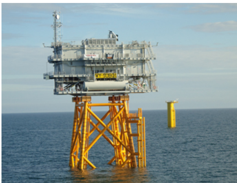
Εικόνα 1 - 5 Εξέδρα τύπου jacket (2B1st Consulting, 2012)
