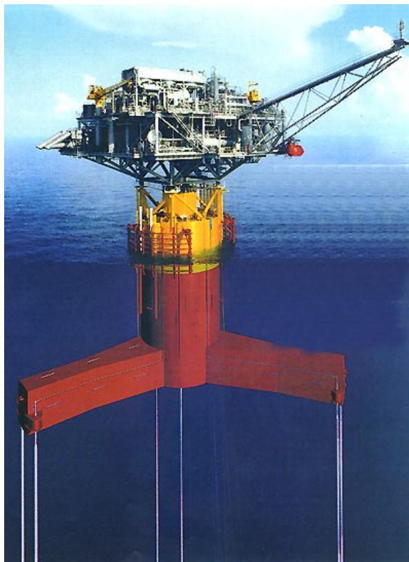
Εικόνα 1 - 11 Εξέδρα τύπου TLP (2B1st Consulting, 2014)
