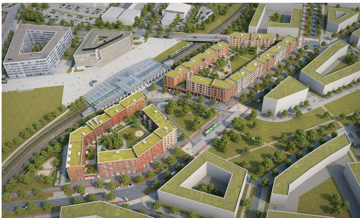
Εικόνα 1: Πράσινη κοινότητα Kronsberg στο Ανόβερο της Γερμανίας (Πηγή: https://www.deltabau.de/aktuelle-projekte/kronsrode-iris-runge-entree/ )
