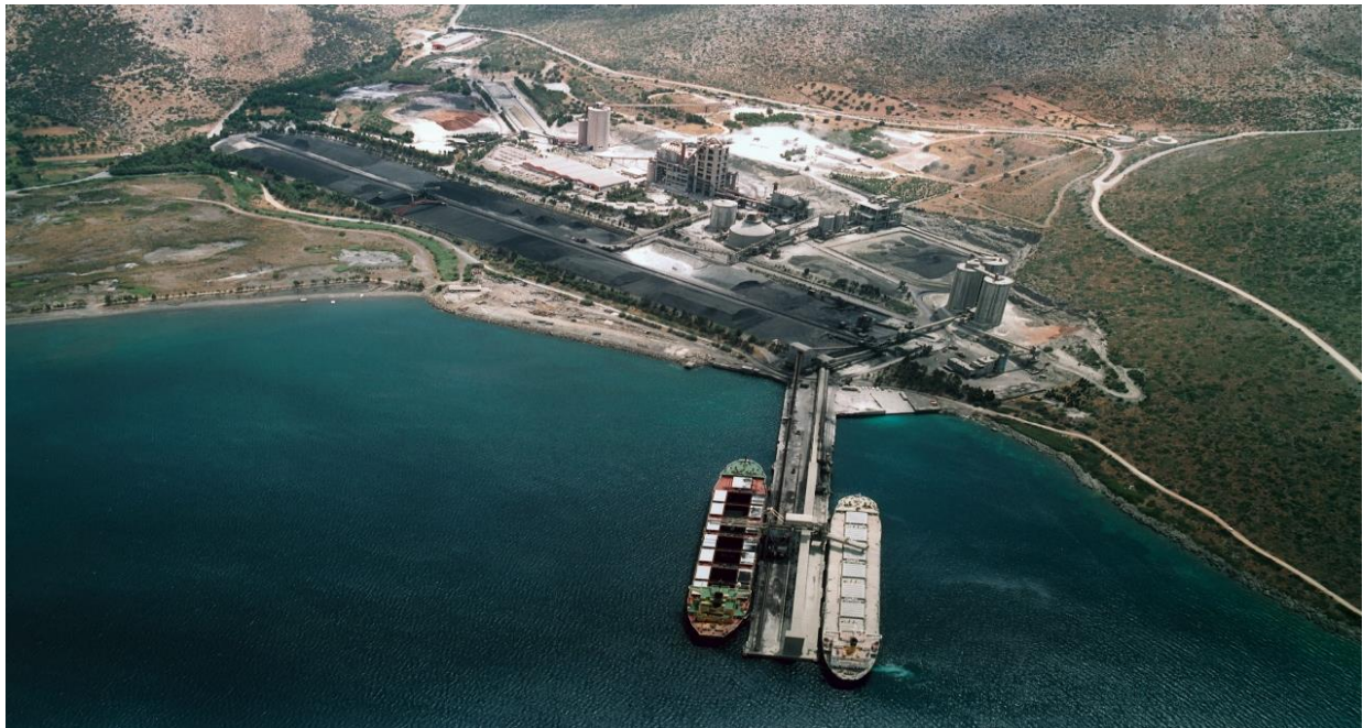
Εικόνα 4.1: Εργοστάσιο παραγωγής τσιμέντου στο Μηλακί, Ευβοίας
