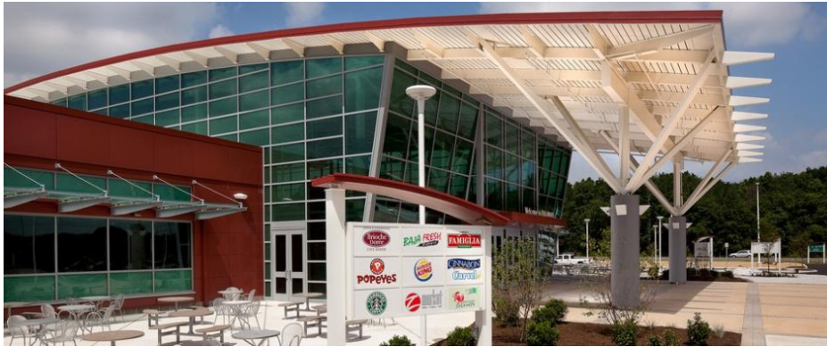
Εικόνα 3.5.3-4. ΣΕΑ - Εμπορικό κέντρο
