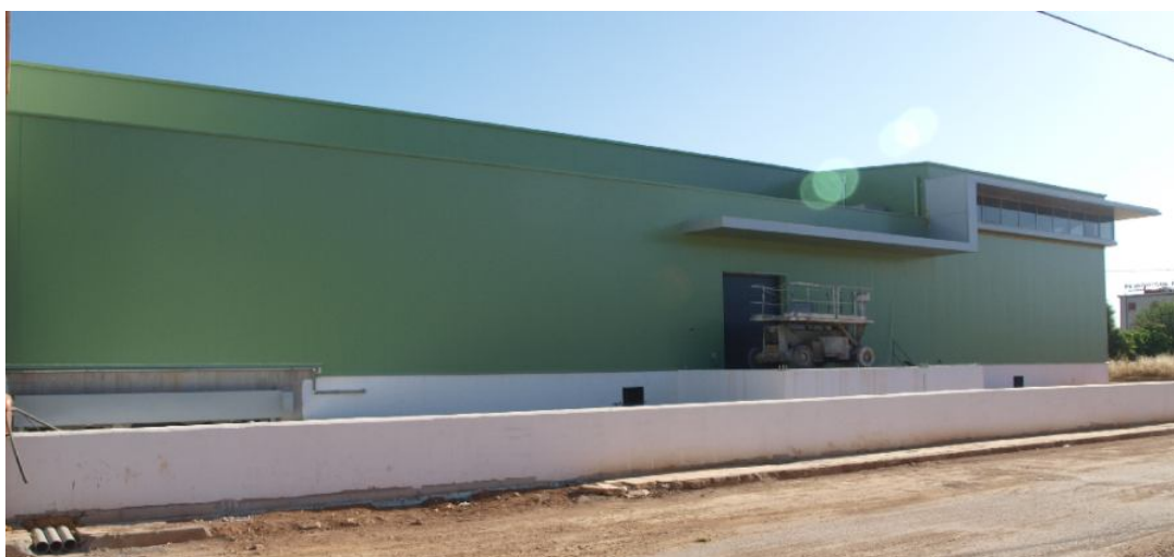
Εικόνα 32Β - Η νέα αποθήκη (Πηγή: Εταιρία)
