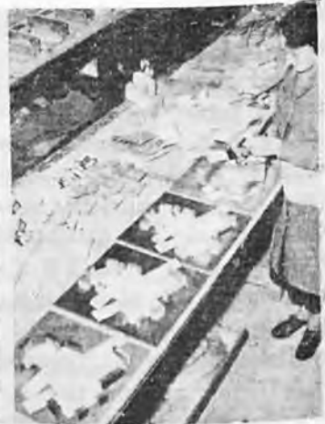
Εικόνα 4. Ἡ χρῆσις ξυλίνων συγχορημάτων συγκατῆσεως διὰ τὴν συναρμολόγησιν σειρᾶς ἐξαρτημάτων ἐπιδείξεως ἐπετάχυνε τὴν παραγωγὴν κατὰ 30 τοῖς ἑκατόν· ὁ χειριστὴς χρησιμοποιεῖ κύλινδρον διὰ νὰ διασφαλίσῃ ὅτι μόνον τὸ ἀναγκαῖον τμήμα δοκιμάζεται.
