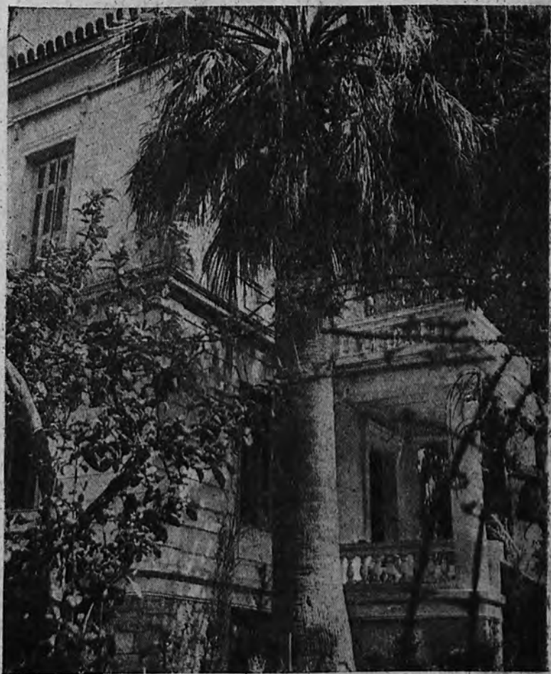
Τὸ ἐπὶ τῆς ὁδοῦ Κύπρου 43 κτίριον τῆς Σχολῆς.
