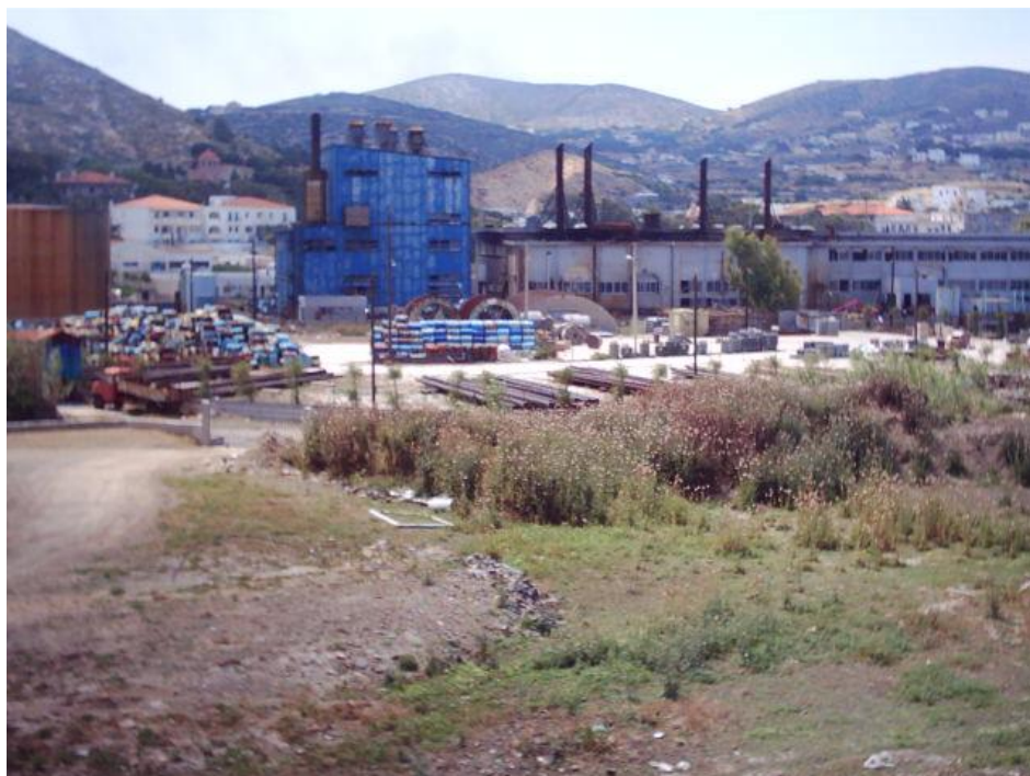
Εικόνα 4-2: Αυτόνομος σταθμός παραγωγής (ΑΣΠ) Σύρου.
