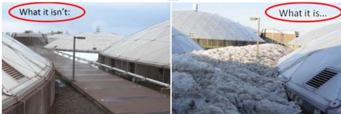
Σχήμα 3.3. Εμφάνιση αφρισμού σε μονάδα επεξεργασίας λυμάτων (Parrella Al., 2011)
