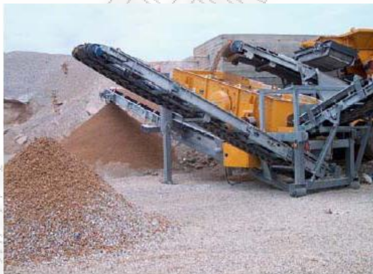
Σχήμα 35 : Άποψη της επιδεικτικής μονάδας ανακύκλωσης ΑΕΚΚ του έργου
