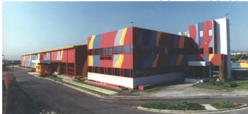
Σχήμα 5.16: Εγκαταστάσεις της εταιρείας «KANAKI» στη Μαγούλα Αττικής.
