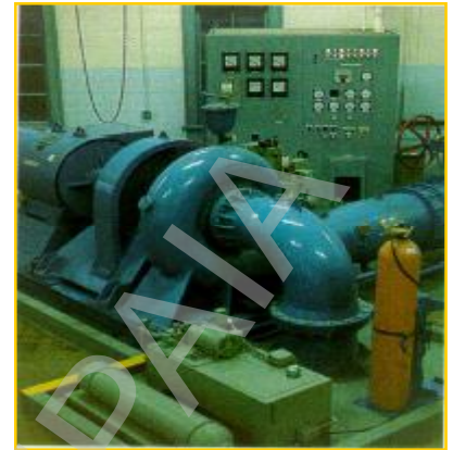
Σχήμα 5.5: Υδροστρόβιλος Francis (Πηγή: Παπαντώνης Δ., "Μικρά Υδροηλεκτρικά Έργα", Εκδ. Συμεών, Αθήνα, 2001)
