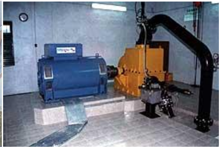
Σχήμα 5.6: Σύγχρονη γεννήτρια εναλλασσόμενου ρεύματος (Πηγή: http://www.dei.gr )
