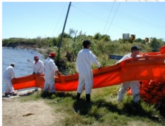
Εικόνα 8.4: Μεταφορά πλωτών φραγμάτων στην ακτή.
