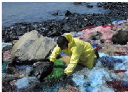
Εικόνα 8.17: Χρήση απορροφητικών υλικών κατά τον καθαρισμό των ακτών.
