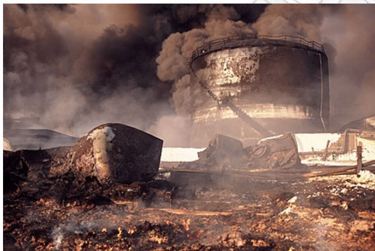
Εικόνα 2.10: Η δεξαμενή πετρελαίου του σταθμού παραγωγής ηλεκτρικού ρεύματος Jieh στο Λίβανο, που βομβαρδίστηκε από ισραηλινές δυνάμεις στις 13 και 15 Ιουλίου 2006.
