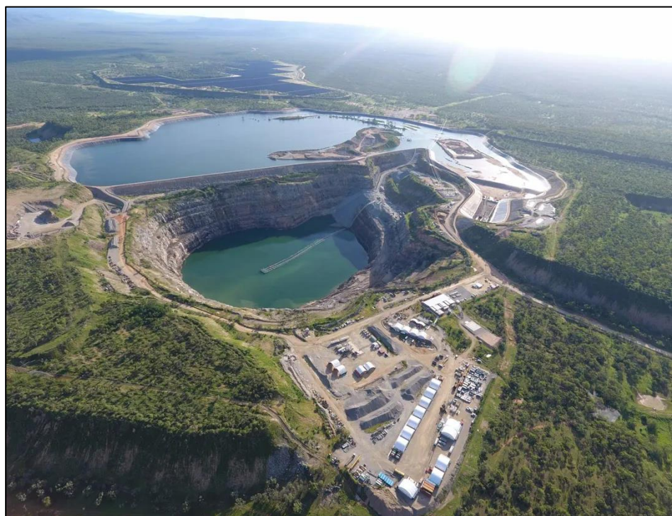
Εικόνα 1.1: Το έργο αντλησιοταμίευσης στο πρώην χρυσωρυχείο Kidston Πηγή: https://www.naif.gov.au/our-projects/genex-kidston-pumped-hydro-storage-project/
