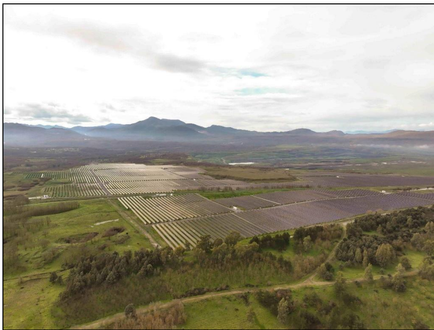
Εικόνα 4.1: Τμήμα του φωτοβολταϊκού σταθμού Μεγαλόπολης.
