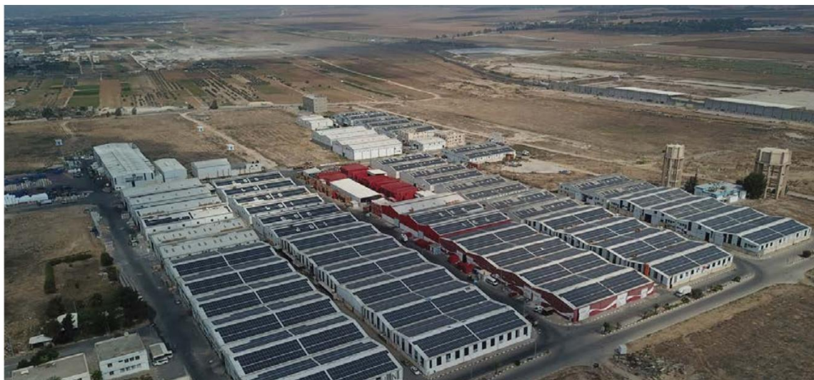
Εικόνα 11 Φωτοβολταϊκά συστήματα εγκατεστημένα στη Βιομηχανική Ζώνη της Γάζας
