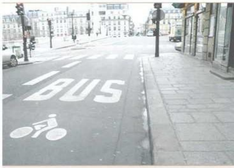
Εικόνα 3.3 : Αποκλειστική λωρίδα για λεωφορεία και ποδήλατα. Δίπλα παραμένει μία λωρίδα μόνο για την υπόλοιπη κυκλοφορία.
