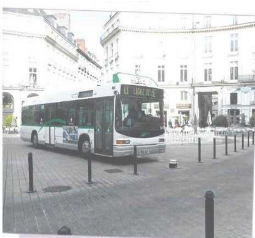
Εικόνα 3.4 : Γαλλία, 2015, οδόστρωμα και πλατεία έχουν πλακοστρωθεί, έχουν την ίδια στάθμη, βυθιζόμενα κολωνάκια αποκλείουν την στάθμευση και επιτρέπουν στα λεωφορεία να κινούνται ελεύθερα.
