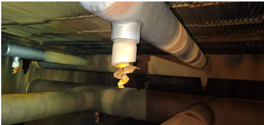
Εικόνα 27. Φθαρμένο ακροφύσιο σε Scrubber.
