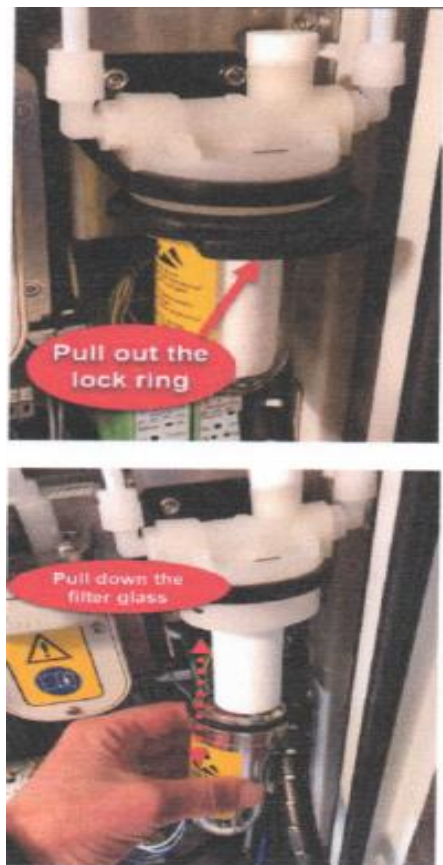
Εικόνα 17. Φίλτρο καυσαερίων δείγματος ratio CO 2 /SO 2
