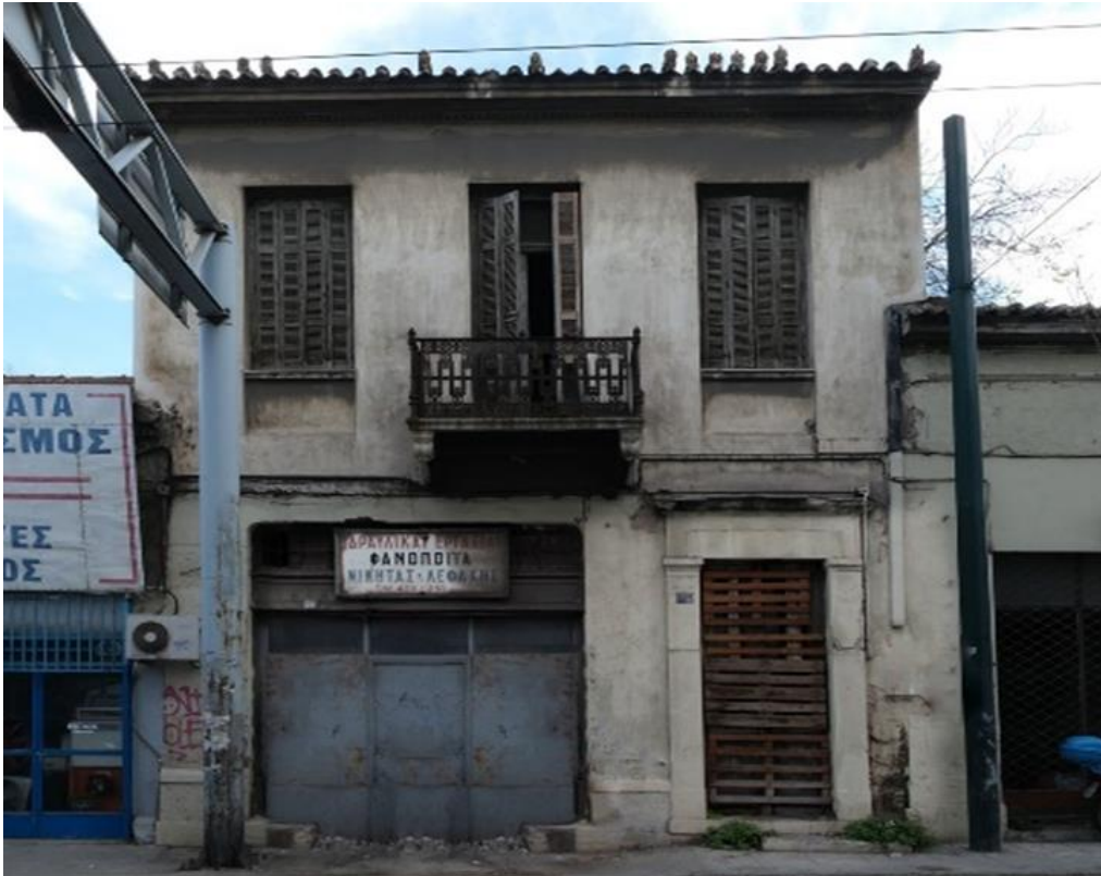
Εικόνα 4.9: Το κτίριο στην οδό Ρετσίνα 26-Ζαλεύκου. Πρόκειται για ένα διώροφο εγκαταλελειμμένο νεοκλασικό. Δεν γνωρίζουμε πολλές πληροφορίες για τη χρήση του
