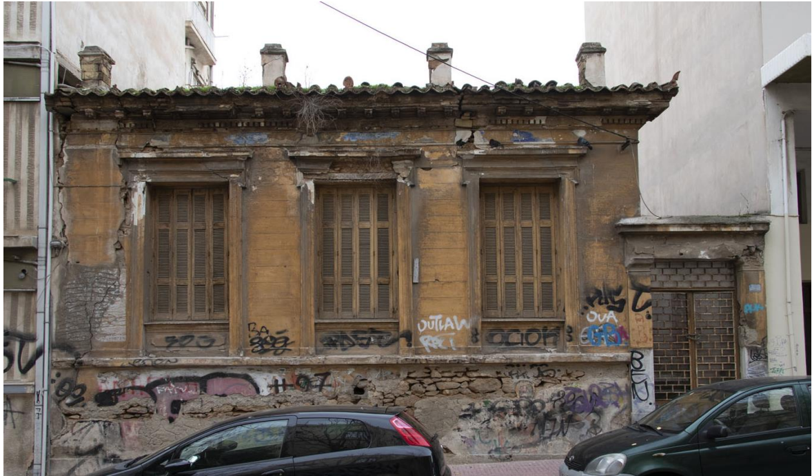
Εικόνα 4.11: Το κτίριο στην οδό Κολοκοτρώνη 19. Λιθόκτιστη οικία με κεραμοσκεπή και εμφανή ίχνη από τα παλαιά επιχρίσματα στις εξωτερικές όψεις. Διακρίνονται μορφολογικά στοιχεία όπως γείσο με οδοντωτή ταινία.
