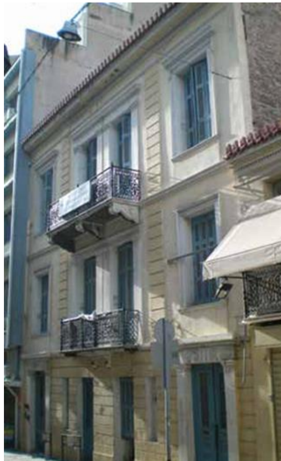
Εικόνα 4.5: Κτίριο στην οδό Νοταρά 32
