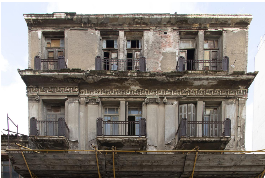
Εικόνα 4.13: Το κτίριο στην Τσαμαδού 15. Τετράωρο κτίριο με έντονα μορφολογικά χαρακτηριστικά. Διακρίνεται για τον ενιαίο εξώστη με καμπύλα κιγκλιδώματα στον α' όροφο και τους τρεις επιμέρους εξώστες στον β'. Ιωνικές παραστάδες, ζώνες από μαιάνδρους και επιρροές Art Deco συνθέτουν την πλούσια αρχιτεκτονική του ταυτότητα
