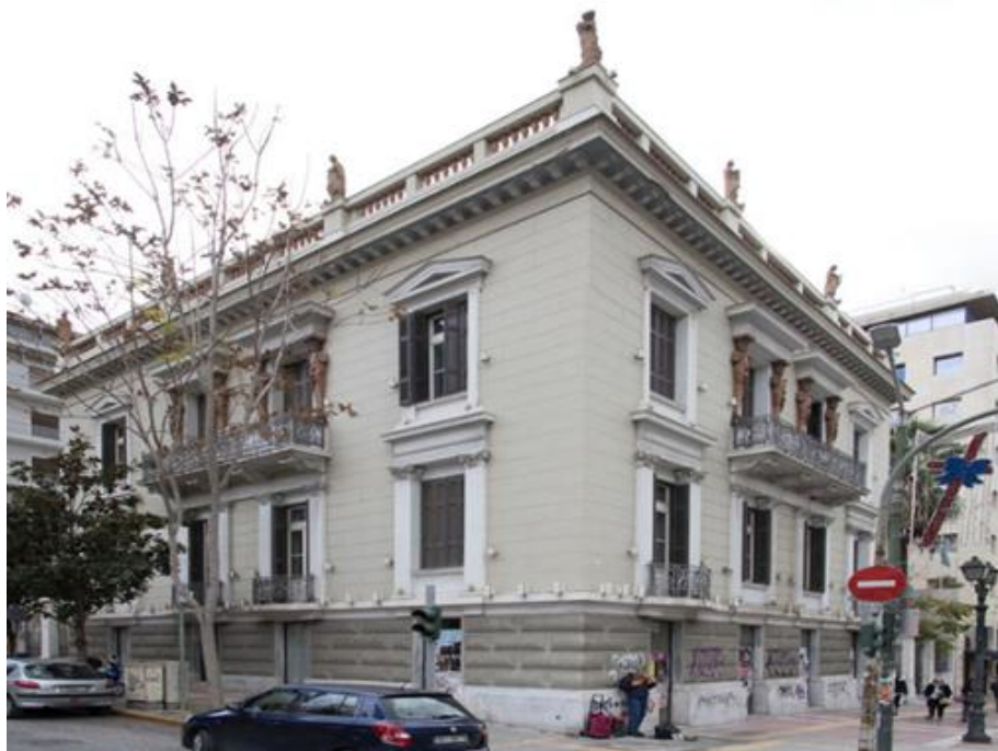
Εικόνα 4.7: Μέγαρο Σπυρίδωνος Μεταξά
