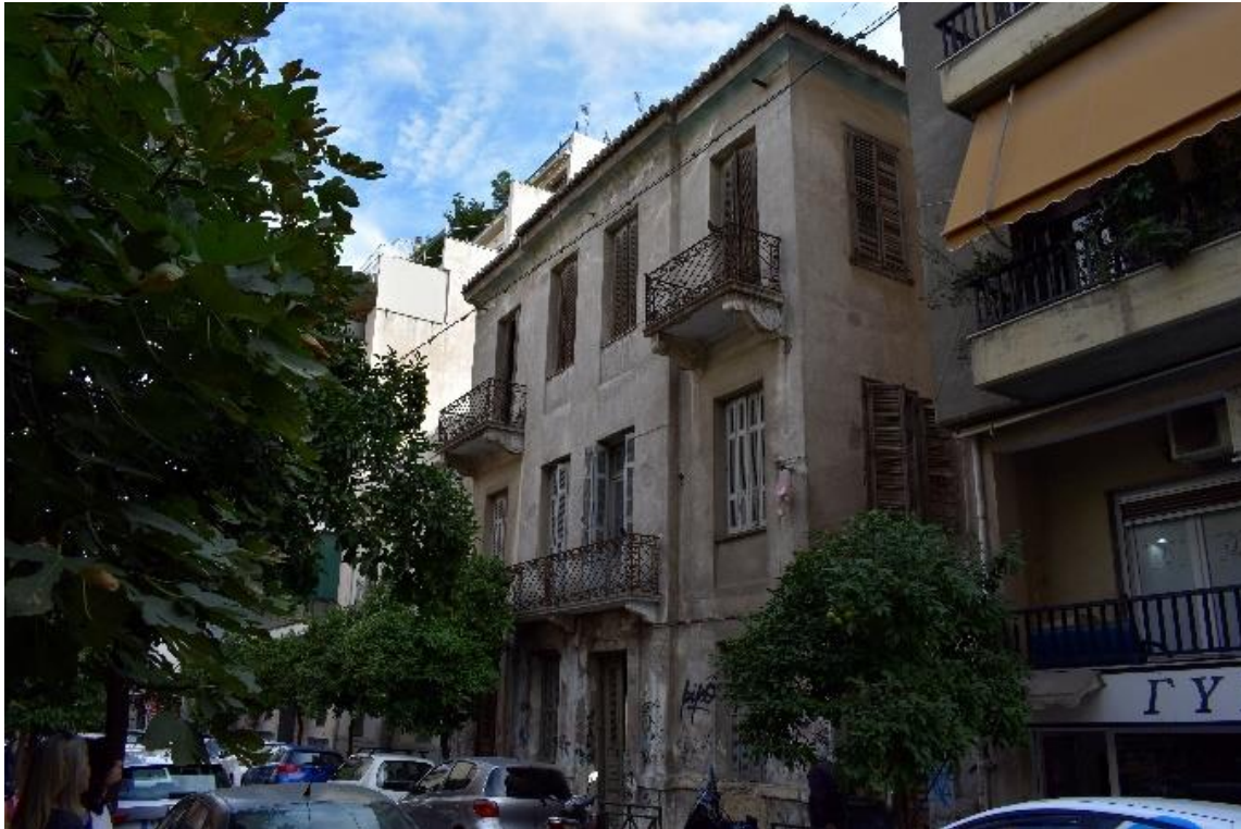
Εικόνα 4.19: Το κτίριο στην οδό Αλκιβιάδου 175, 175Α, 175Β. Πρόκειται για τριώροφο νεοκλασικό κτίριο του τελευταίου τετάρτου του 19ου αιώνα. Η χρήση του ήταν ιδιωτική κατοικία.
