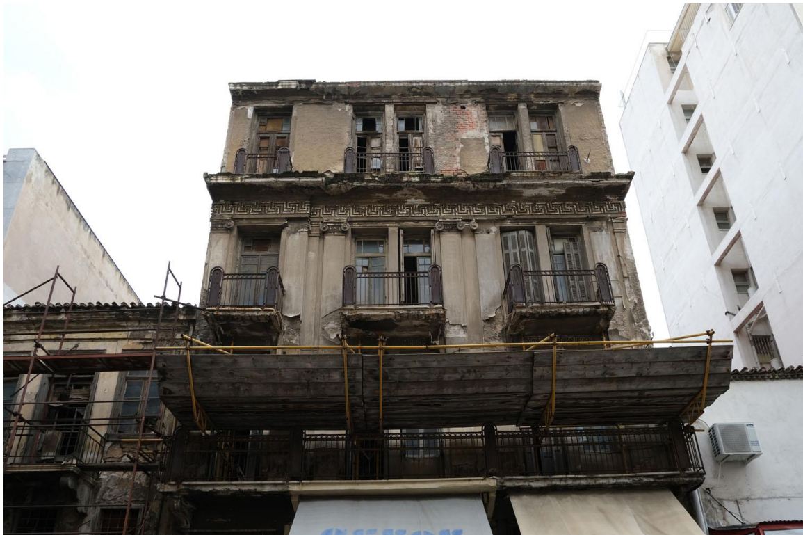
Εικόνα 4.12: Το κτίριο την οδό Τσαμαδού 13. Τριώροφο νεοκλασικό κτίριο, καλυμμένο ωστόσο με σκαλωσιές, που δεν επιτρέπουν την μορφολογική μελέτη της όψης του. Διακρίνονται οριζόντιες διακοσμητικές ζώνες στο επίπεδο της απόληξης της στέγης.
