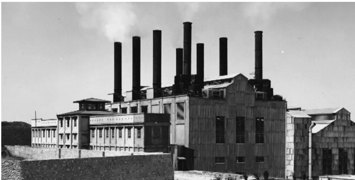
Εικόνα 38: Ο ατμοηλεκτρικός σταθμός Αγίου Γεωργίου Κερατσινίου.
