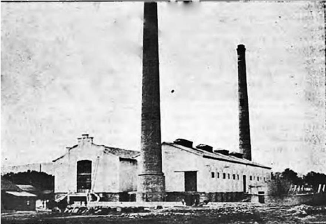
Εικόνα 36: Ο ατμοηλεκτρικός σταθμός Νέου Φαλήρου. Πηγή: https://pireorama.blogspot.com/2019/02/
