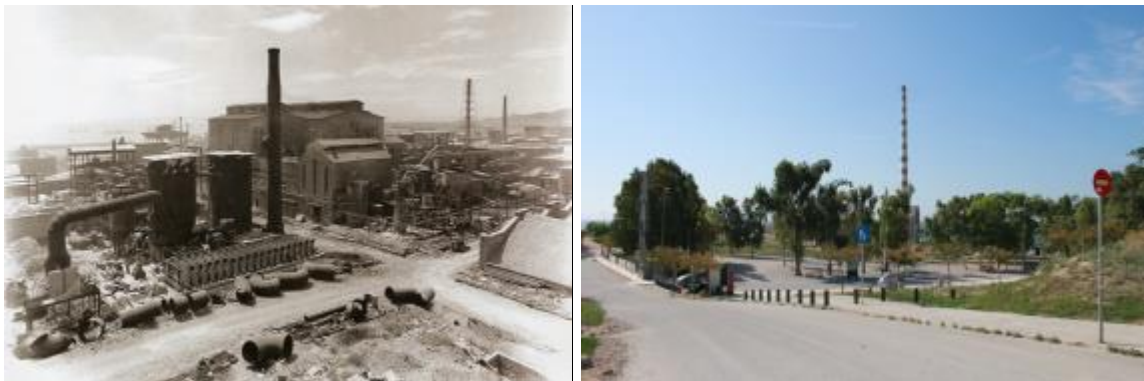
Αριστερά Εικόνα 60: Γενική άποψη του εργοστασίου κατά τη δεκαετία του 1980. Πηγή: Μαΐστρου Ε., κ.ά, Ανόνημη Ελληνική Εταιρεία Χημικών Προϊόντων και Λιπασμάτων (1909-1993) Λιπάσματα Δραπετσώνας . Πολιτιστικό Ίδρυμα Ομίλου Πειραιώς.
