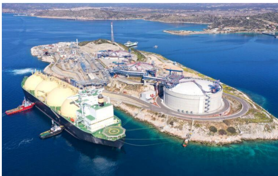
Εικόνα 3 Τερματικός σταθμός Ρεβυθούσας. Πηγή: Money Review, Greek Economy Η Ρεβυθούσα κρατά όρθια με φυσικό αέριο τη Βουλγαρία
