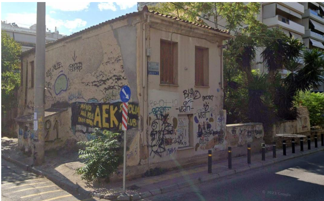
Εικόνα 24. Οικία στην οδό Χαζηταποστόλου. (Πηγή: googlemaps).
