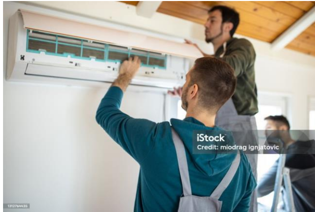
Εικόνα 11: Τοποθέτηση κλιματιστικού
