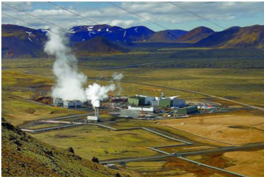
Εικόνα 7-Γεωθερμικός Σταθμός Παραγωγής στην Ισλανδία- ΠΗΓΗ : https://www.power-technology.com/projects/hellisheidi-geothermal-power-plant/
