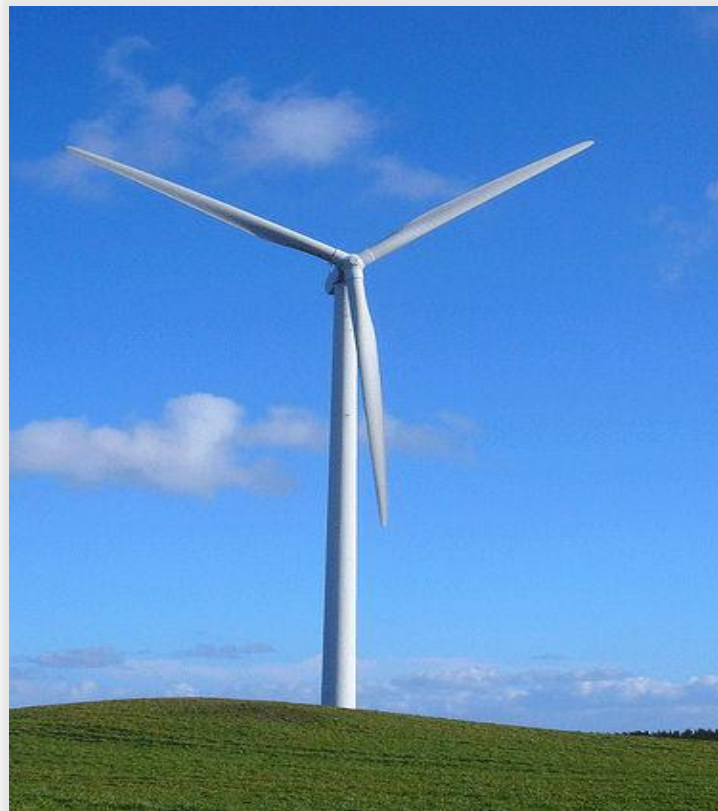
Εικόνα 4: Ανεμογεννήτρια οριζόντιου άξονα
