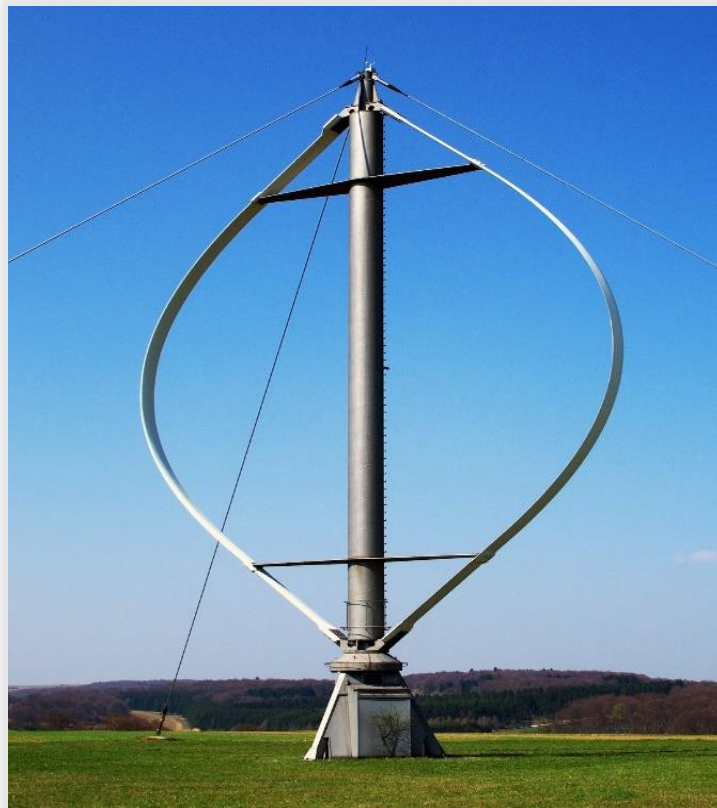
Εικόνα 5: Ανεμογεννήτρια κάθετου άξονα
