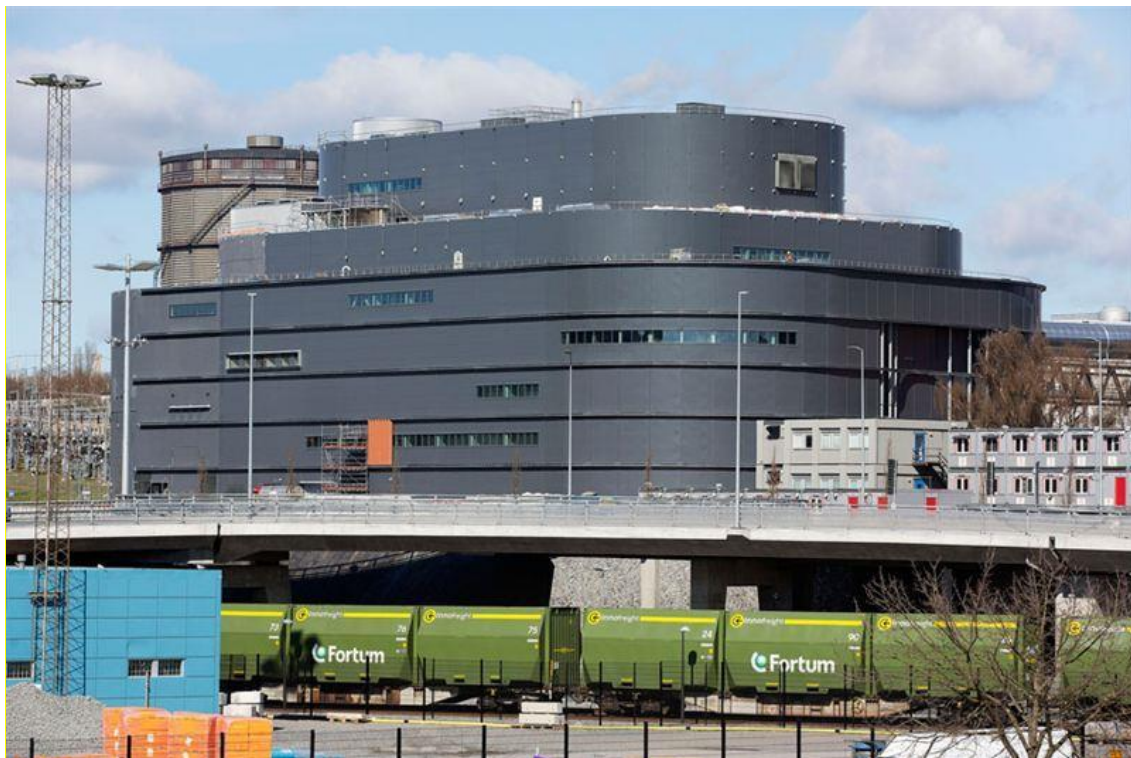
Εικόνα 4. 4Värtaverket biofuelled CHP plant in Stockholm
