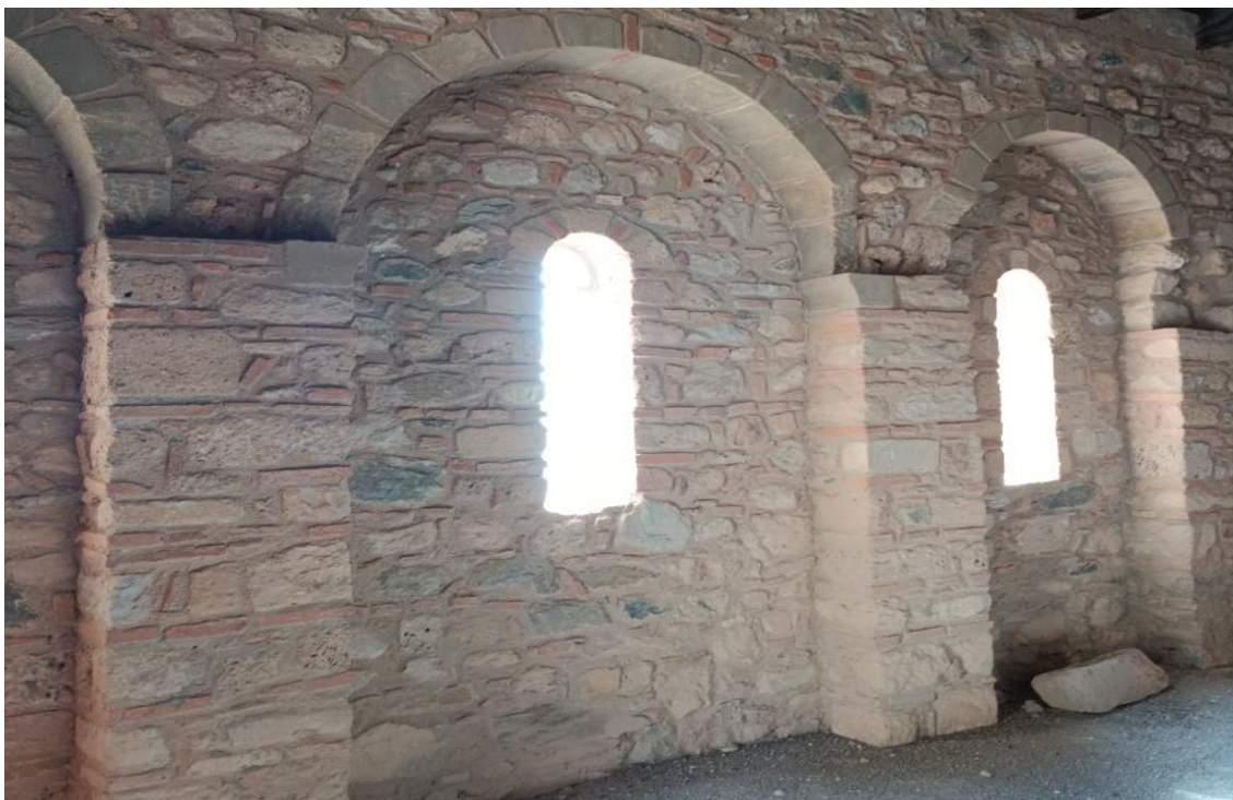
Εικόνα 4.13: Τμήμα των αφιδωμάτων με παράθυρα.
