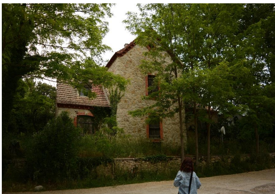
Εικόνα 25. Κτήριο των αξιωματικών της φρουράς (Φωτογραφία).
